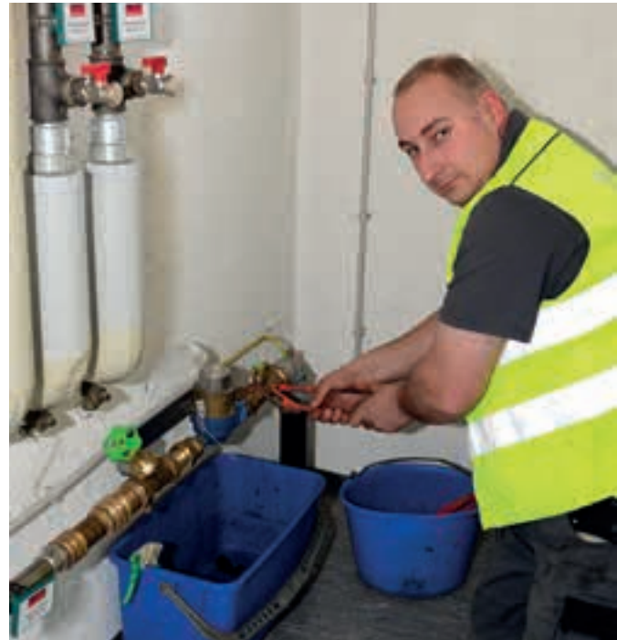
So will es das Eichgesetz: Stefan Hubl, ein Monteur vom Wasserwerk der Stadtwerke Weilheim, tauscht einen alten Wasserzähler gegen einen neuen aus.
