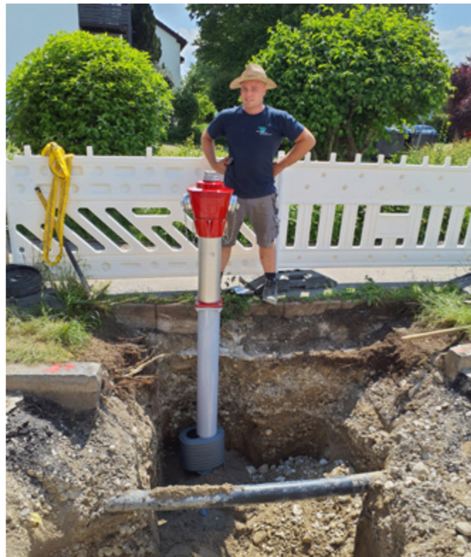
Thomas Osterseher, Fachkraft der Abteilung Wasser und Kollegen vom Betriebshof der Stadtwerke setzen einen neuen Hydranten
