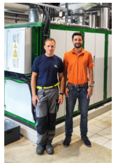
Das neue, größer dimensionierte BHKW verarbeitet mehr eigenes Klärgas bzw. Biogas und erzeugt so mehr Strom, von links: Alexander Fath Abteilungsleiter Kläranlage, Lukas Becker, Bereichsleiter Wasser & Abwasser, beide Stadtwerke
