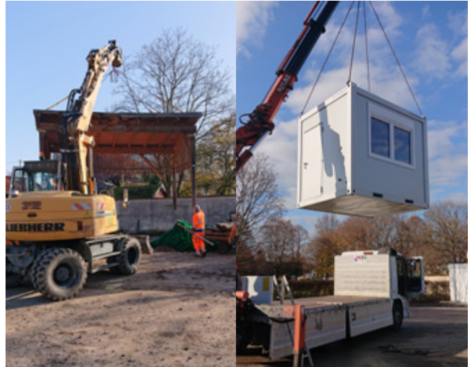
Links: Rückbau alter Unterstände Rechts: Der neue Sozialcontainer wird platziert.
