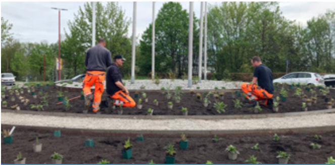
Mitarbeiter unseres Bereichs Betriebshof haben die Mittelinsel zurückgebaut, die Stein- und Erdarbeiten gemacht und neu bepflanzt, von links: Erhan Cetinkaya, Gregor Leisching, Simon Gutheil
